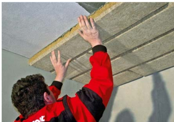
Obrázek č. 2: Lepení tepelněizolačních lamel na strop
