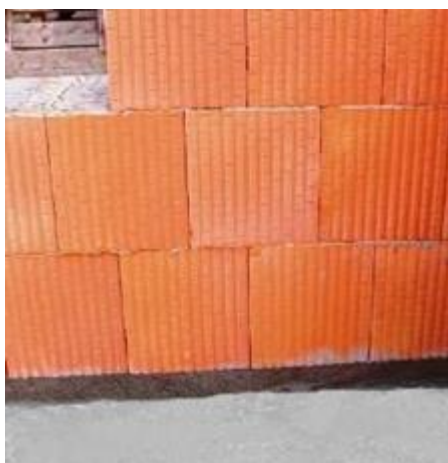
Po zavadnutí se zakládací malta seřízne do roviny
