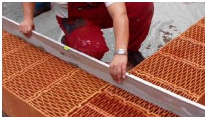
Kontrola a srovnání povrchu první řady
