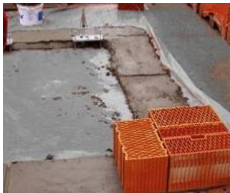
Skladba cihelných tvarovek na rohu
