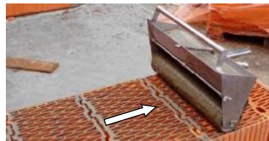
Nastavením optimální štěrbinu a pohybem válce dopředu se hmota nanáší na blok
