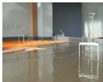
Strojní aplikace potěru na podlahové topení
