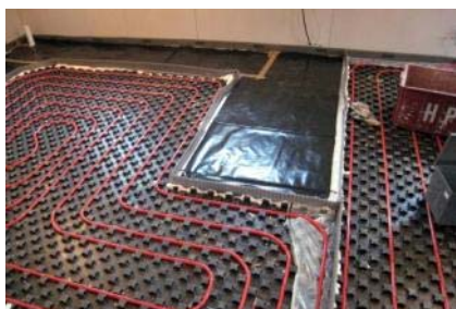
Podklad s fixovaným topným potrubím
