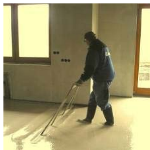
Zarovnání, odvzdušnění a homogenizace čerstvého potěru
