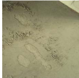
Silnější krusty je nutné odstranit přebroušením
