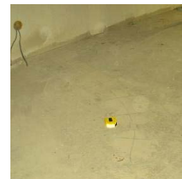
Sanace praskliny lepením a sponkováním
