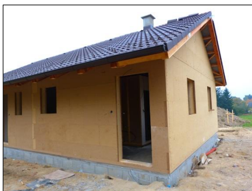
Obr. 2: Příklad opláštění dřevostavby dřevovláknitými deskami
