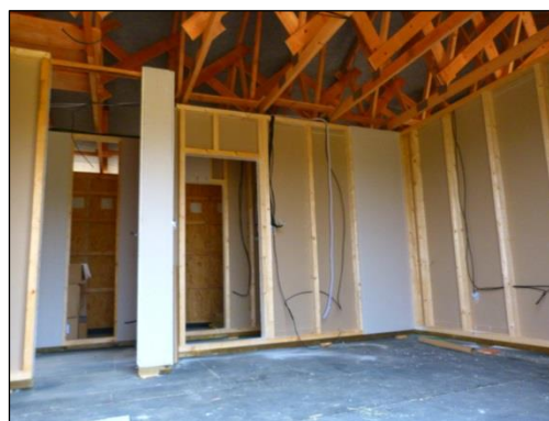
Obr. 3 Vnitřní konstrukce dřevostavby
