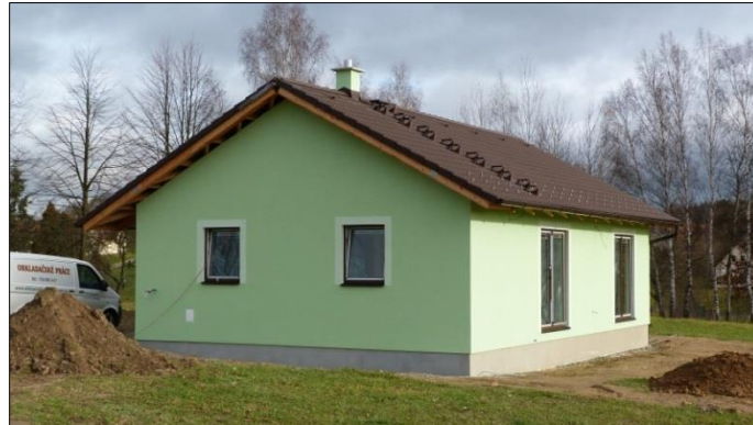
Obr. 7: Hotová fasáda objektu
