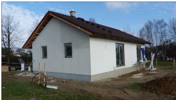
Obr. 4: Objekt opatřený základní vrstvou
