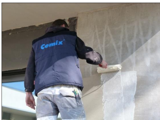
Obr. 5: Provádění penetračního nátěru omítky
