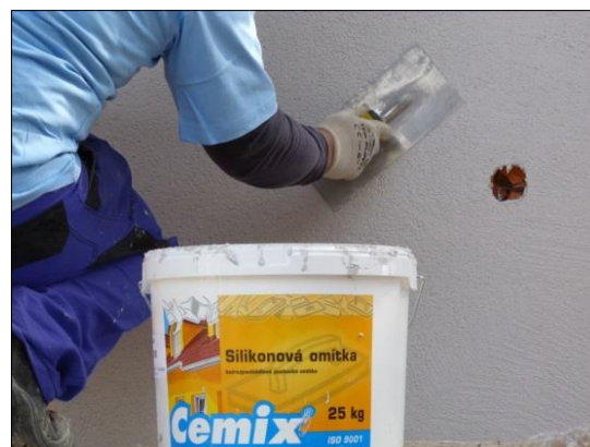
Obr. 6: Natahování strukturální omítky
