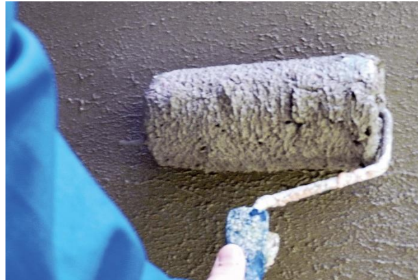
Obr. 2 Nanášení polymercementového můstku
