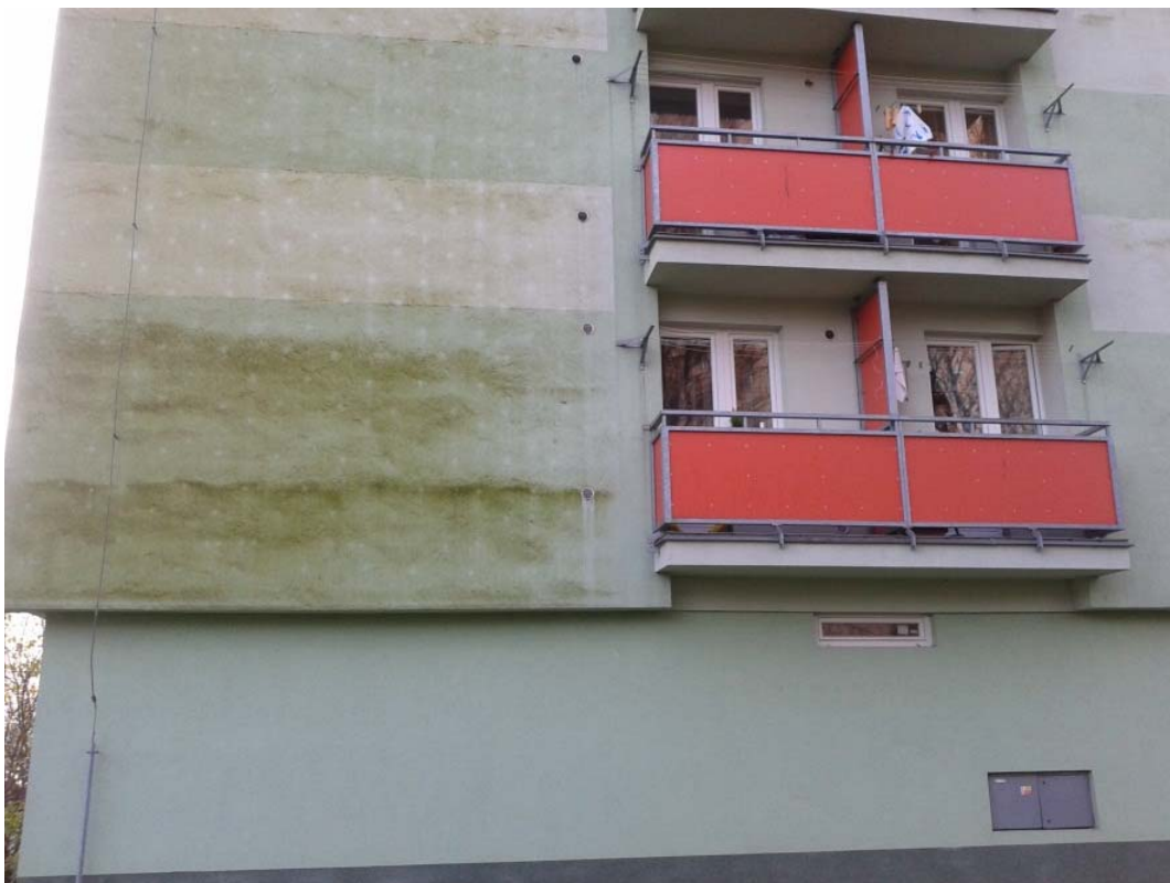
Obr. 1: Příklad výskytu biotického porostu na zateplené fasádě
