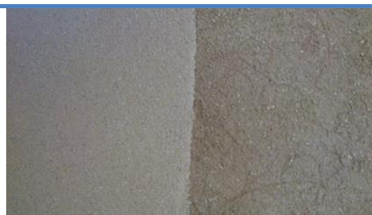
Obr. 9 Jemná omítka na jádrové omítce
