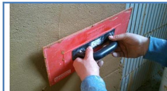
Obr. 8 Natahování omítky hladítkem
