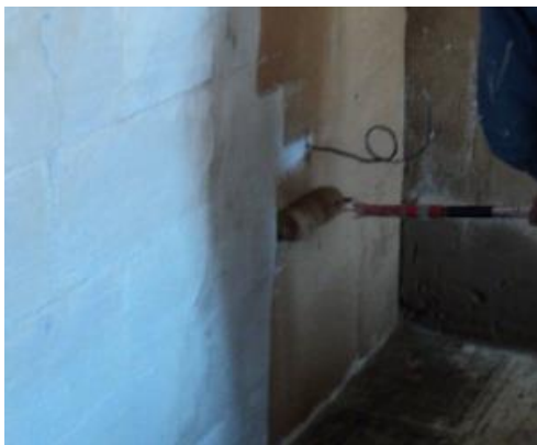
Obr. 3 Nanášení spojovacího můstku válečkem
