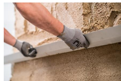
Obr. 7 Stahování omítky latí
