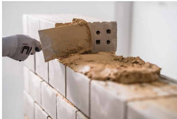
Obr. 2 Promaltování vodorovných i svislých spár
