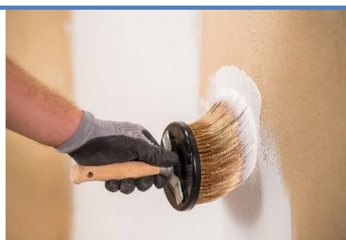
Obr. 11 Provádění nátěru
