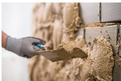
Obr. 5 Ruční nanášení omítky
