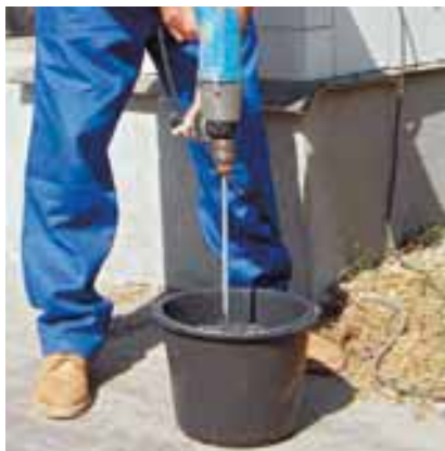
Míchání a příprava zdicí malty
