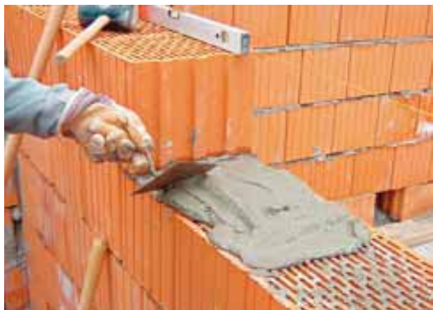
Nanášení malty na ložnou spáru
