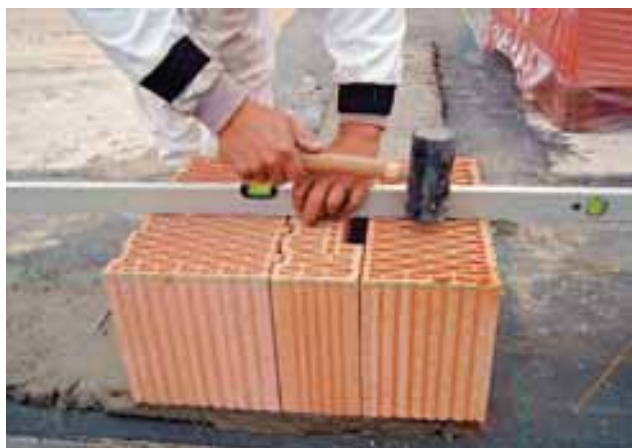
Skladba cihelných tvarovek na rohu
