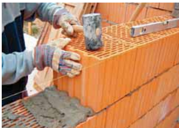
Přesné uložení bloku a jeho srovnání
