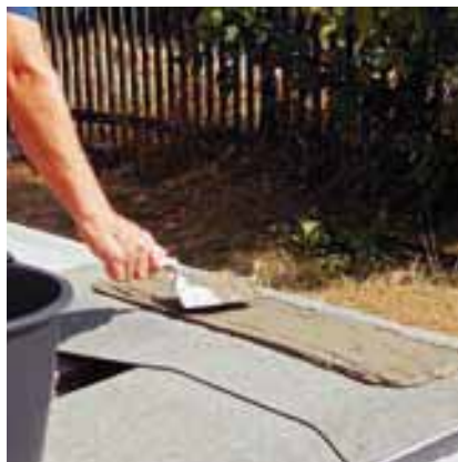
Nanášení malty pro uložení první řady bloků
