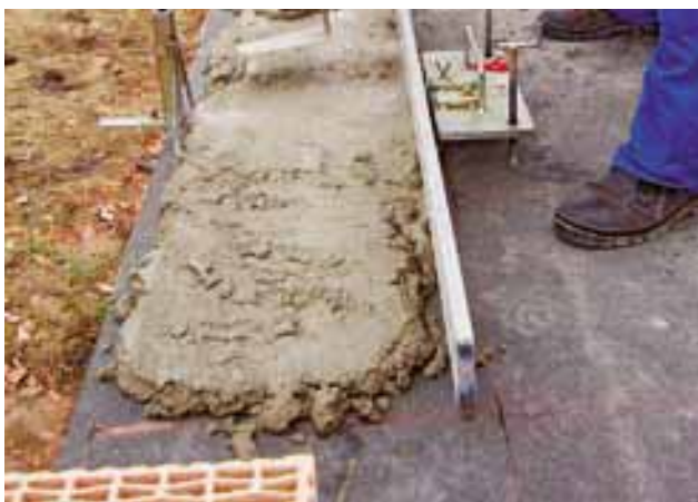
Nanášení a urovnání zakládacího maltového lože
