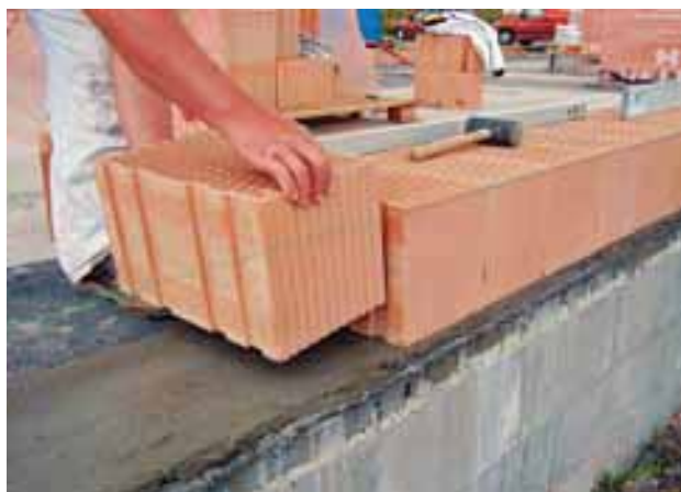
Ukládání a kontrola tvarovek první řady
