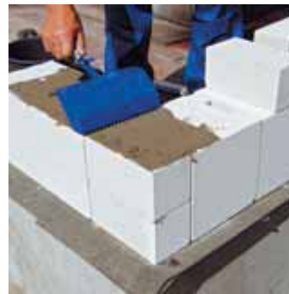
Nanášení malty do ložné spáry mezi bloky
