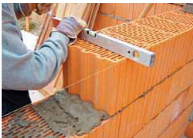
Vyrovnaní bloku do roviny
