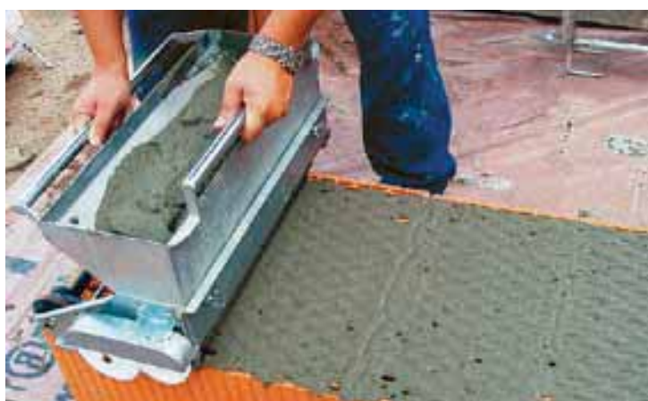
Kladení zdicí malty pro celoplošnou tenkou spáru
