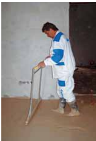
Zarovnání, odvzdušnění a homogenizace čerstvého potěru
