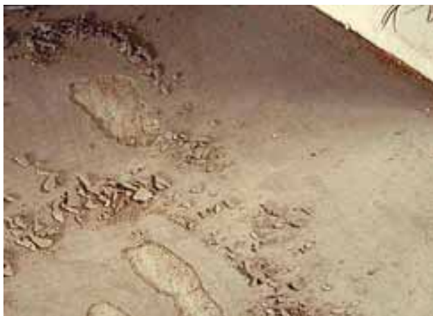
Silnější krusty je nutné odstranit
