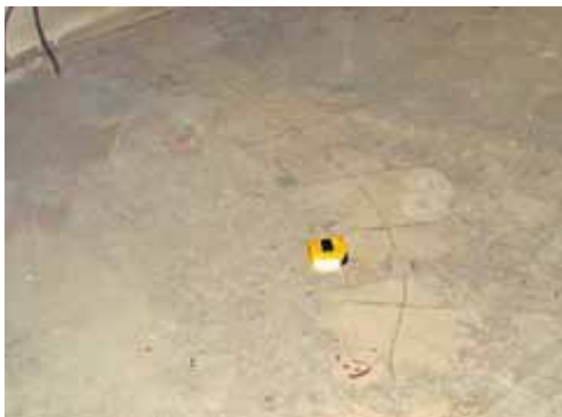
Sanace praskliny lepením a sponkováním
