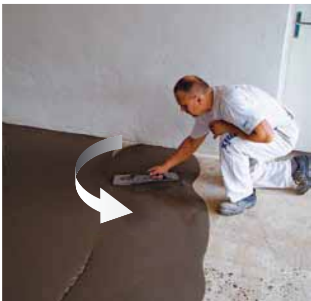
Vyrovnání zubovým hladítkem
