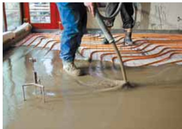
Strojní lití potěru na podlahové topení
