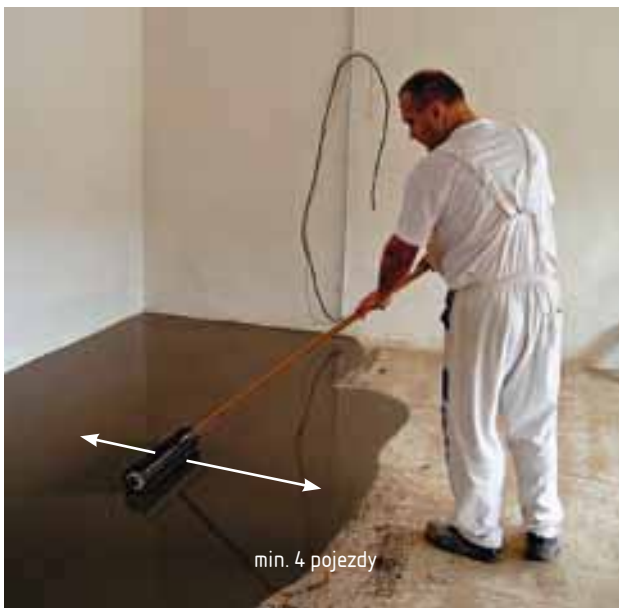
Odvzdušnění ježkovým válečkem
