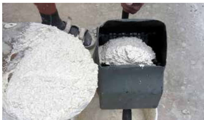
Plnění omítacího mlýnku
