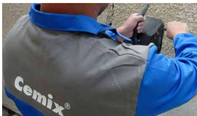
Aplikace ručním stříkáním / vytváření stříkané struktury
