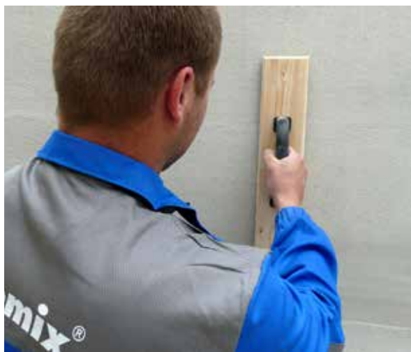
Zdrsňení povrchu ocelovou škrabkou
