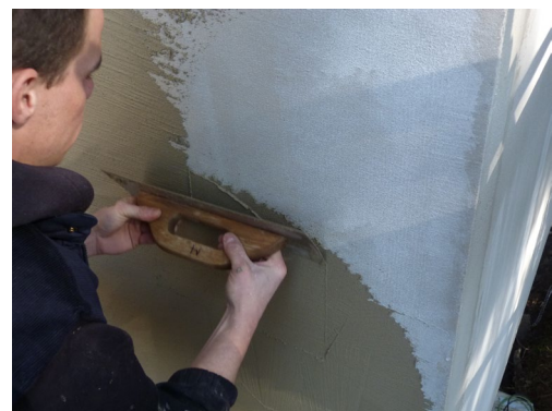
↗ Přestěrkování povrchu Cemix 155 Vyrovnávací sěrku MULTI
