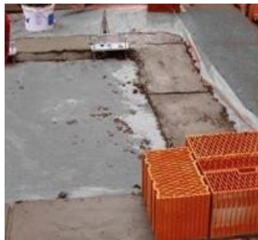
▲ Zahájení zdění v rohu objektu
