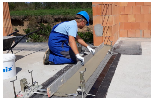
▲ Nanášení a vyrovnání malty pomocí vyrovnávací soupravy
