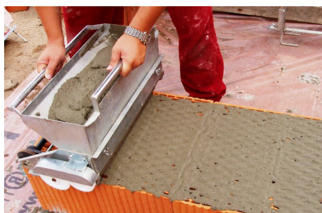
▲ Nanášení malty pomocí maltového vozíku
