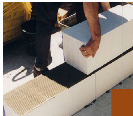
▲ Osazování tvarovek do nanesené malty
