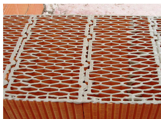
➤ Malta nanesená pouze na žebra cihel
