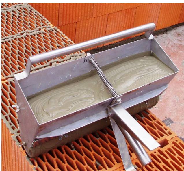
➤ Nanášení malty pomocí maltového válce
