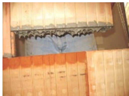
➤ Osazení příčkovky po předchozím namočení do malty
