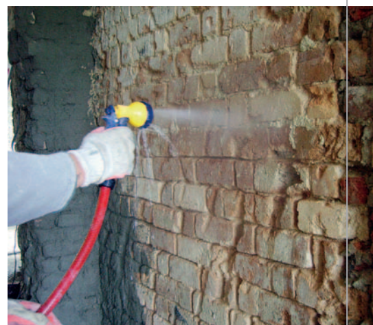
celoplošné vlhčení podkladu
