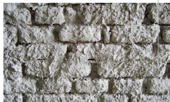
Provedení postříku materiálem Cemix 084 SUPERSAN hrubý
