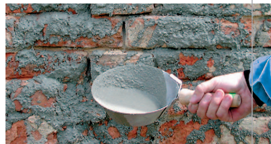
Provedení postříku materiálem Cemix 044 Sanační podhoz WTA
