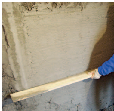
Nanášení jádrové omítky
