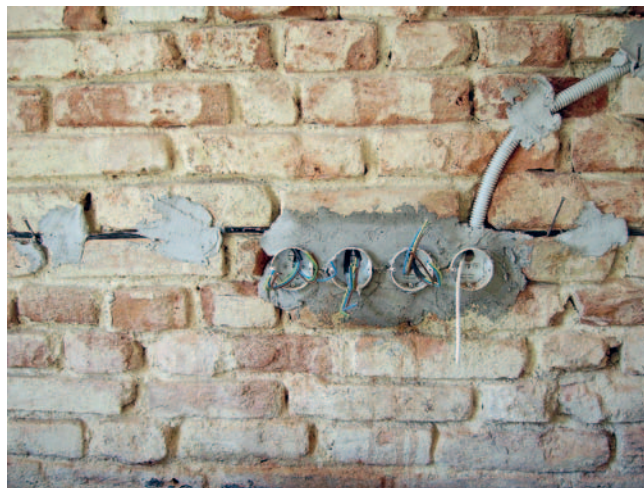
➤ Upevnění instalací
