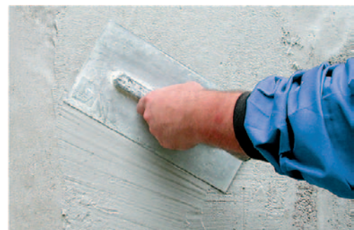
▲ Nanášení Cemix 034 Sanační omítky štukové
