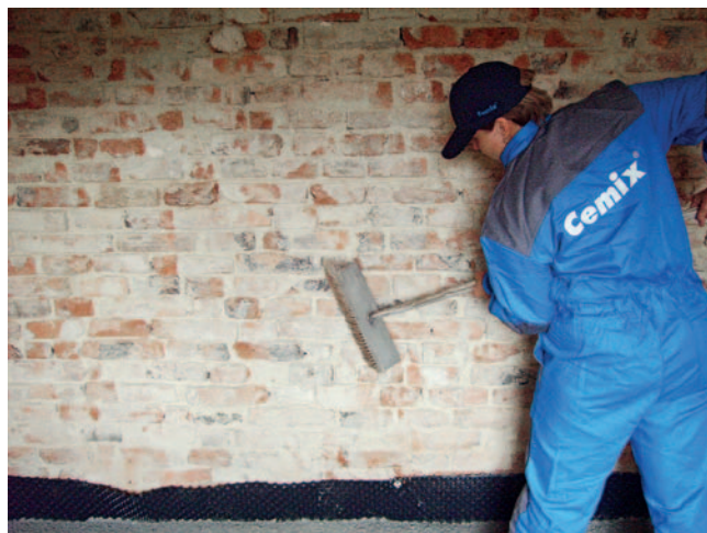
➤ Ometení podkladu
