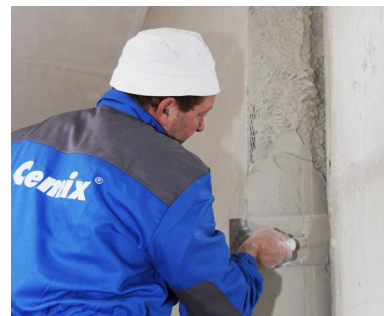
✔ Zkouška zavadnutí omítky
