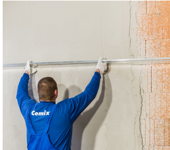
✔ Dorovnání omítky trapézovou latí
