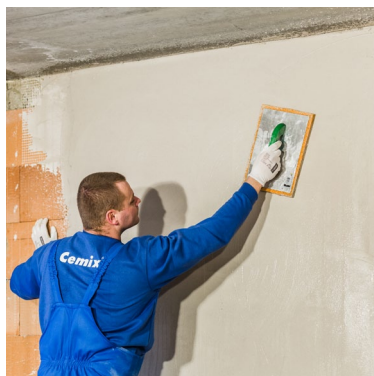
✔ Vytažení šlemu ze zvlhčeného povrchu
