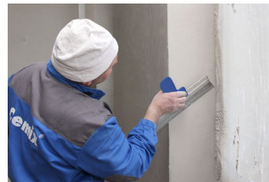
✔ Úprava špalety po výměně okna
