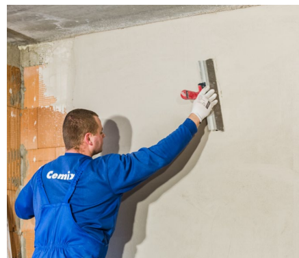
✔ Úprava povrchu gletováním
