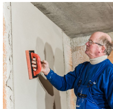
✔ Úprava povrchu filcováním
