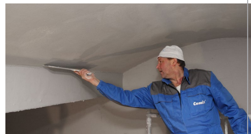
✔ Osazení rohového profilu
