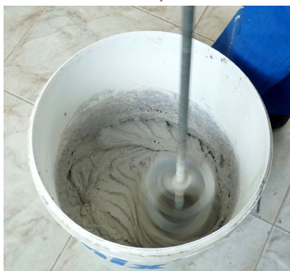
✔ Ruční míchání omítky
