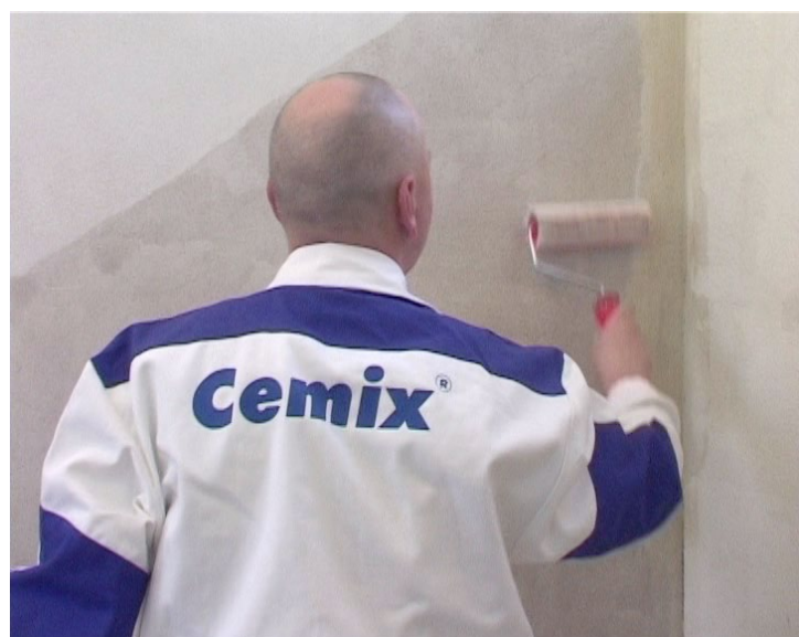
▲ Nanášení můstku Cemix Kontakt BETON
