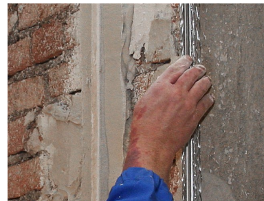
✔ Nanášení omítky do špalety
