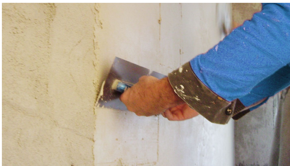
Upravení štukové vrstvy
