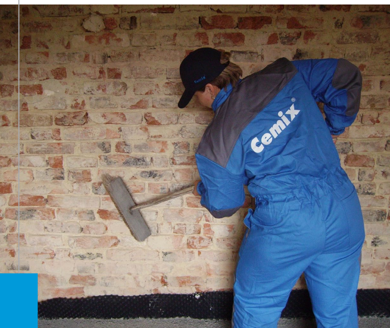
▲ Očištění zdiva
