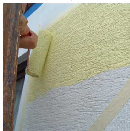
▲ Nanášení finálního nátěru
