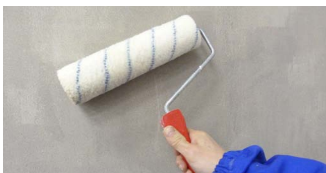
Penetrace podkladu (jádrové omítky nebo stěrkové hmoty)
