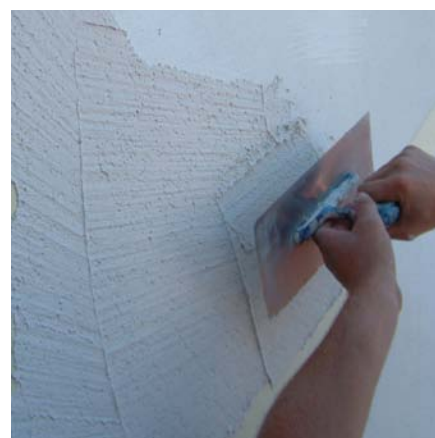
▲ Nanášení zatírané a rýhované omítky
