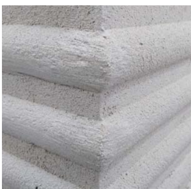
➤ Tahy zubovým hladítkem na nároží
