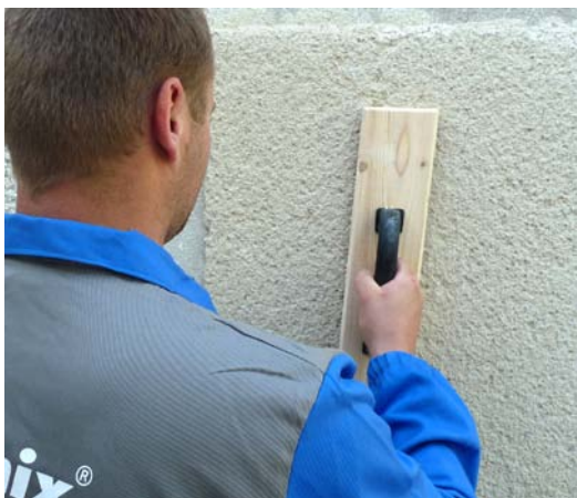
▲ Vytváření struktury škrábáním
