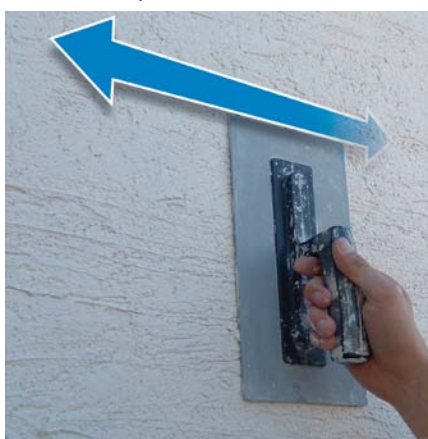
▲ Vytváření rýhované struktury
