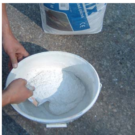
▲ Rozmíchání minerální omítky s předepsaným množstvím vody
