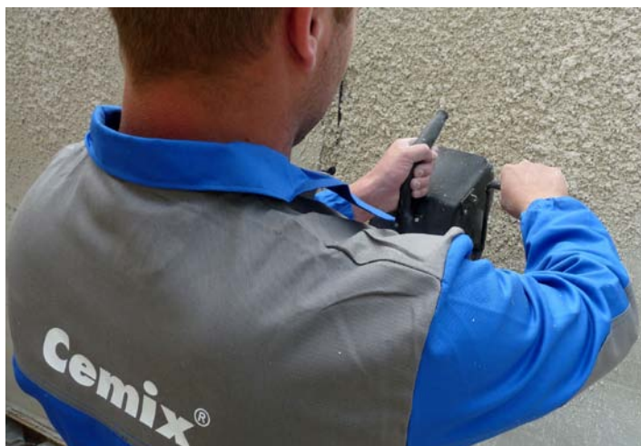
✓ Vytváření stříkané struktury
