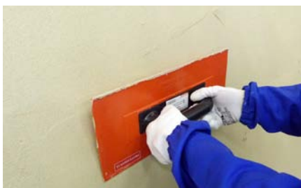
▲ Natažení štukové omítky
