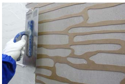
Natažení štukové omítky
