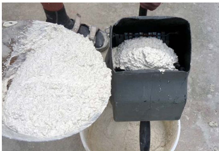
✓ Aplikace ručním stříkáním
