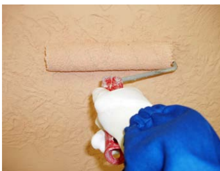
▲ Opatření povrchu fasádním nátěrem
