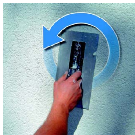
▲ Vytváření zatírané struktury
