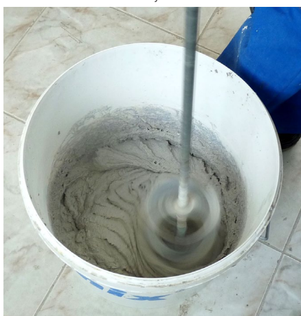
♥ Ruční míchání omítky
