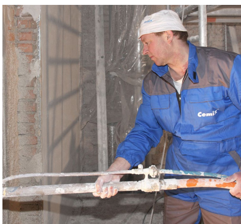
♥ Strojní nanášení omítky
