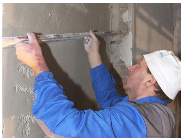
♥ Stahování omítky latí
