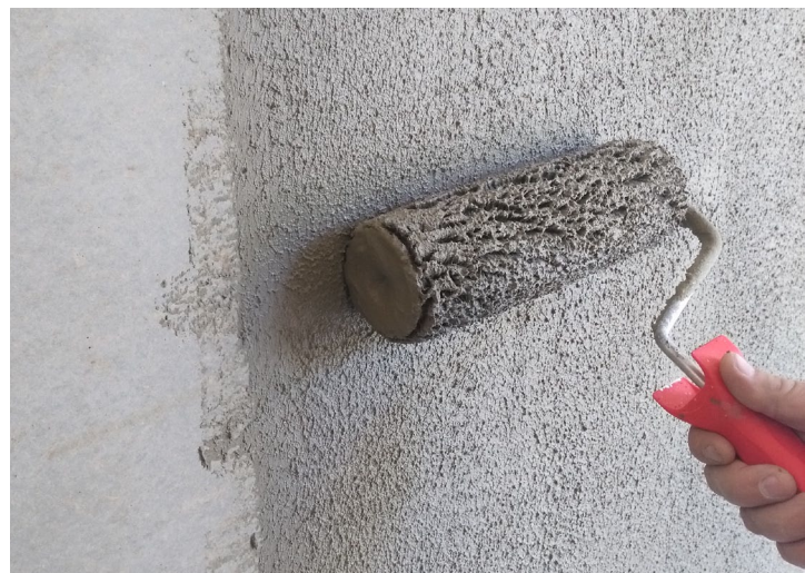
↗ Nanášení Cemix 221 Polymercementového spojovacího můstku
