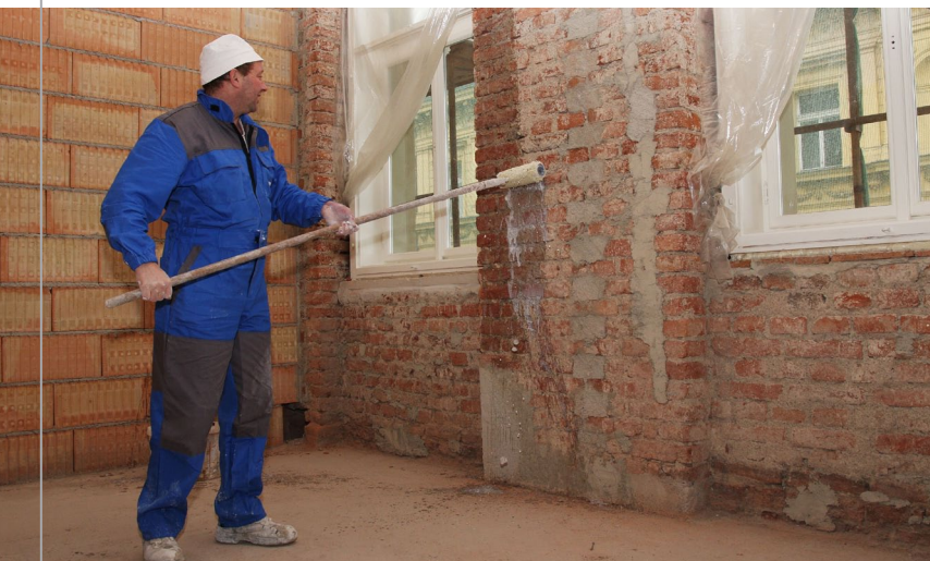
↗ Nanášení Cemix Penetrace základní
