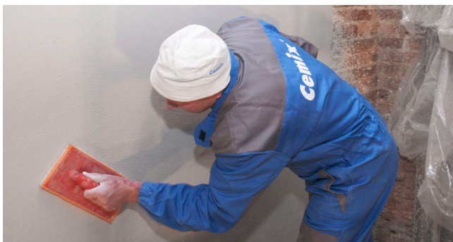
♥ Vytažení šlemu ze zvlhčeného povrchu
