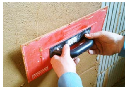
▲ Vyrovnání jemnou omítku
