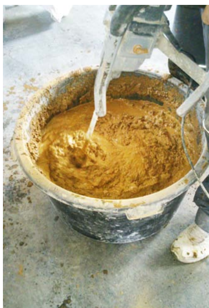
▲ Rozmíchání omítky rychloběžným míchadlem
