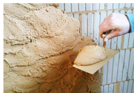
▲ Nahazování jádrové omítky
