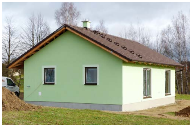
➤ Hotová fasáda po aplikaci zatírané omítky, před její aplikací byl podklad ošetřen Cemix Penetrací ST COLOR
