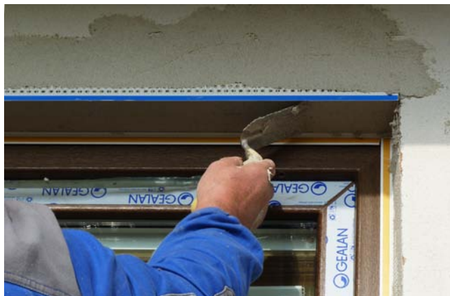
➤ Materiál Cemix 185 Lepicí a stěrková hmota DIFUZNÍ se zpracovává běžným způsobem a používá se také k instalaci systémových profilů
