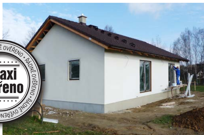
➤ Stavba po celoplošné aplikaci Cemix 185 Lepicí a stěrkové hmoty DIFUZNÍ za současného vkládání armovací tkaniny
