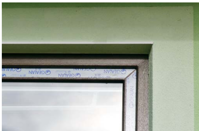
➤ Hotová fasáda v detailu
