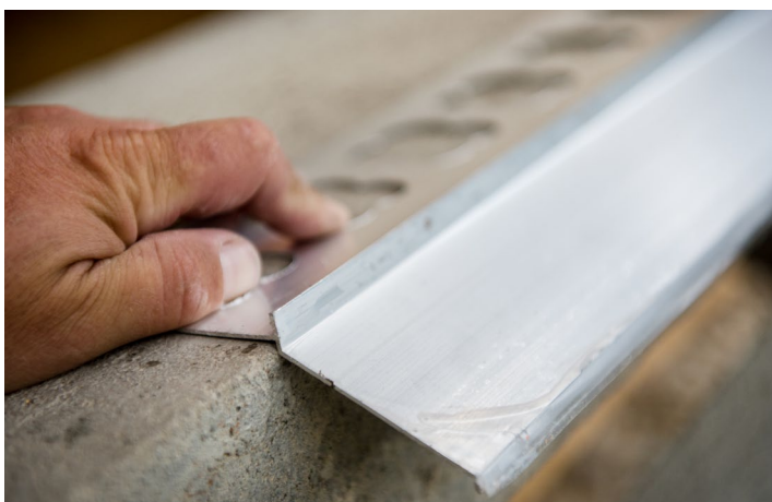
▲ Provizorní usazení profilu
