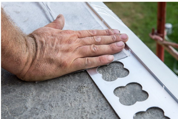
▲ Uchycení plechu Samolepicím butylovým pásem
