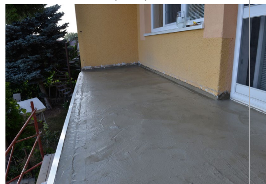
▲ Hydroizolace ve dvou vrstvách nátěru
