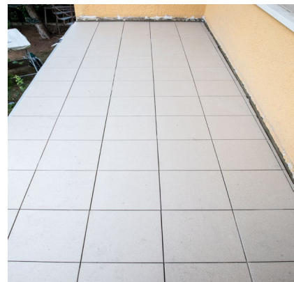
▲ Hotový vyspárovaný povrch
