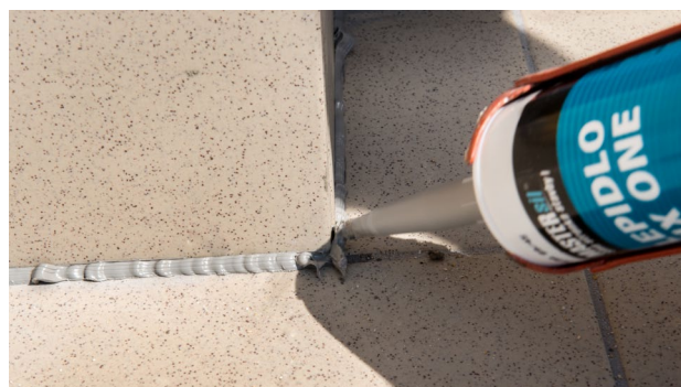
▲ Tmelení styku stěna podlaha
