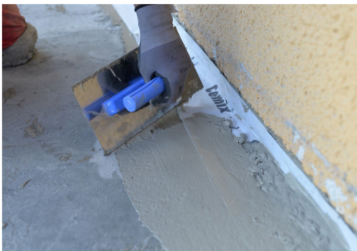
▲ Aplikace druhé vrstvy hydroizolační stěrky
