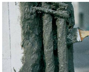
▲ Aplikace antikorozní ochrany výztuže
