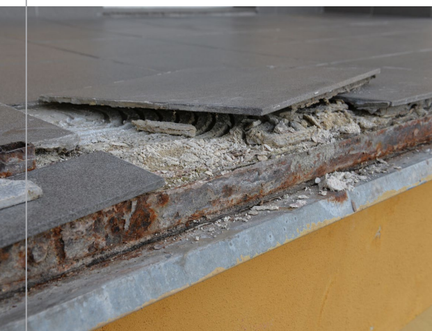
▲ Odstranění uvolněných částí povrchu balkonů
