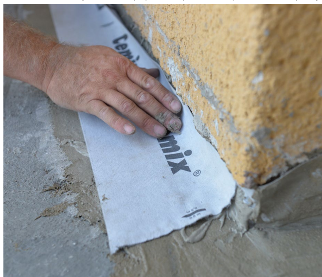
Pružná těsnicí páska v první vrstvě hydroizolace
