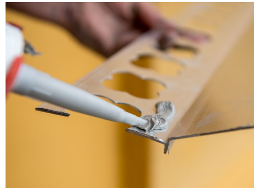
▲ Silikon pro provizorní usazení profilu
