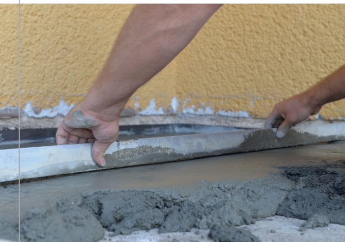
Vytváření spádového klínu
