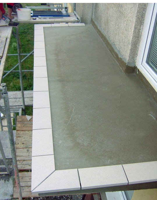
▲ Osazení keramické tvarovky
