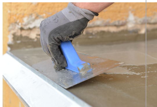
▲ Dotažení hydroizolace až k hraně balkonového profilu
