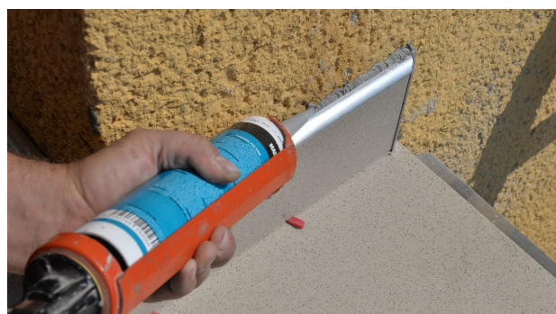
▲ Tmelení soklové hrany
