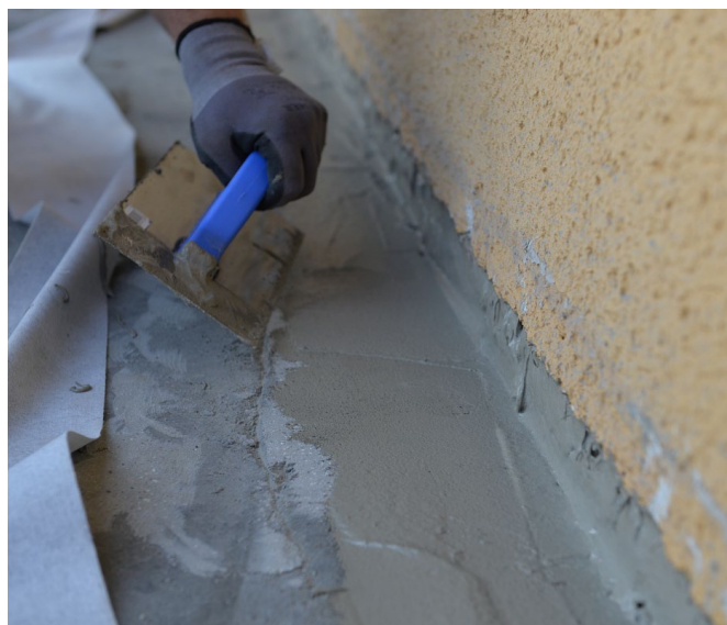
První vrstva hydroizolace připravená pro vložení pružné těsnicí pásky
