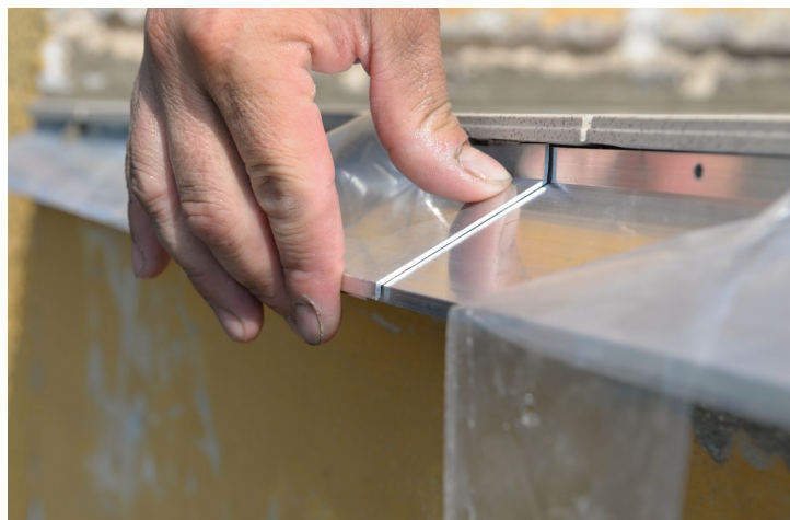
▲ Opatření spojkou profilu
