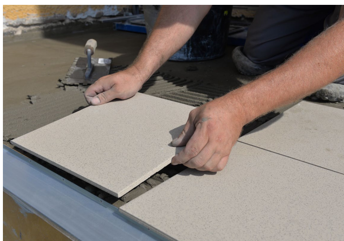
▲ Lepení dlažby od okraje balkonu
