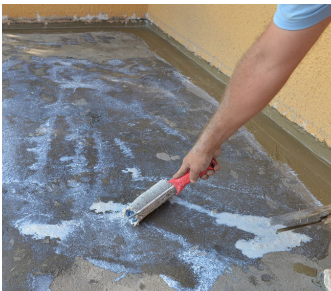
Penetrace podkladu
